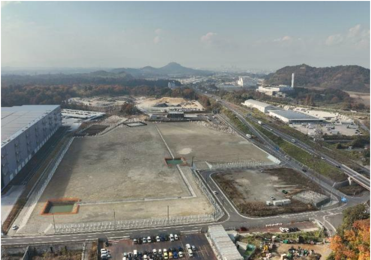
写真：石部造成二期工事
